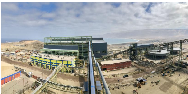
首钢秘铁二期扩建工程投入使用
