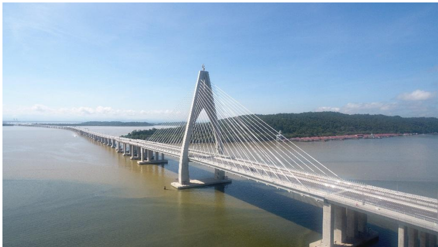
中资企业参与承建的文莱淡布隆跨海大桥
